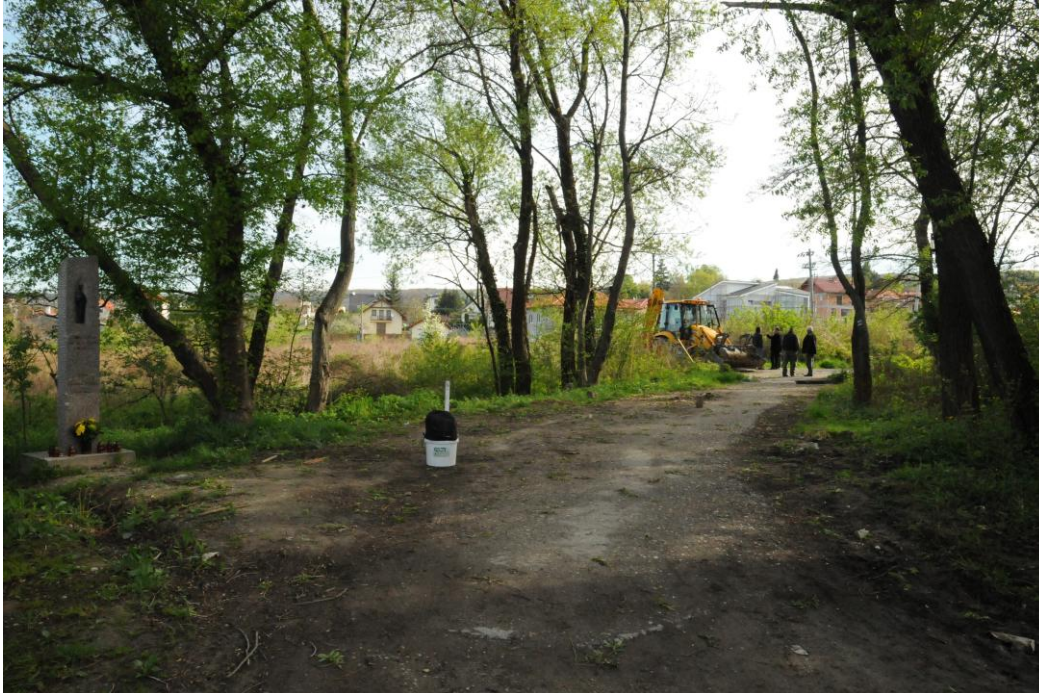
Stav pred rekonštrukciou
