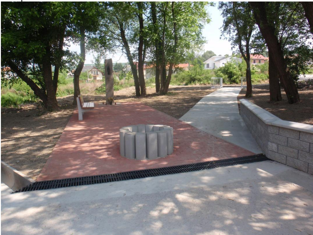
Stav po rekonštrukcii
